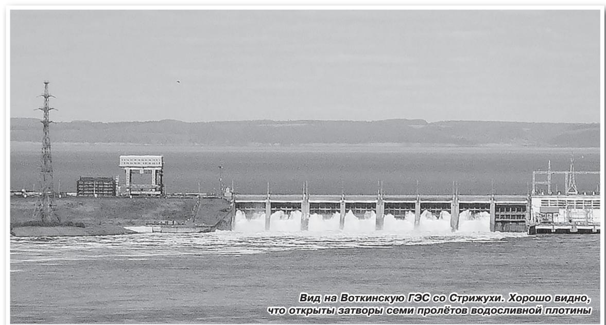
Вид на Воткинскую ГЭС со Стрижухи. Хорошо видно, что открыты затворы семи пролётов водосливной плотины
