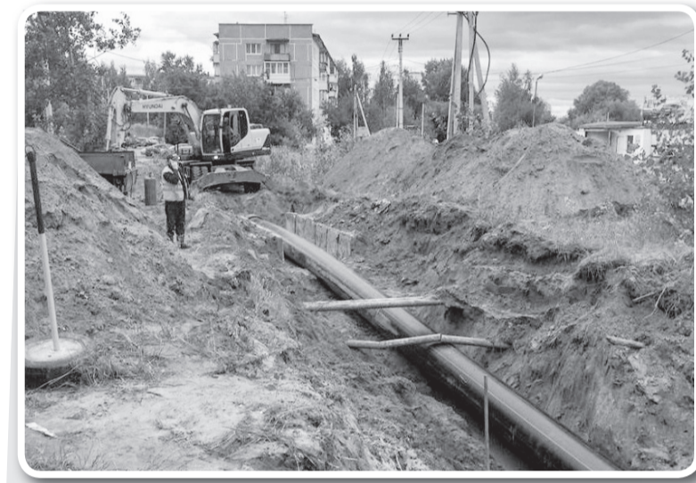
Замена водопровода в районе лицея «Синтон»
